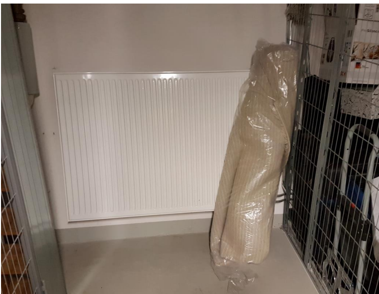
Bild 13: E18, källarplan, förrådsutrymmen.
